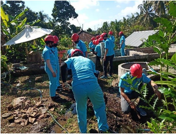
Gambar 7. Penanaman Kabel Power Dan Pemasangan Panel Control
