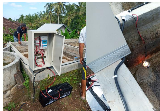
Gambar 9. Testing dan komisioning Panel Control PLTS, Instalasi Penerangan dan Aki
