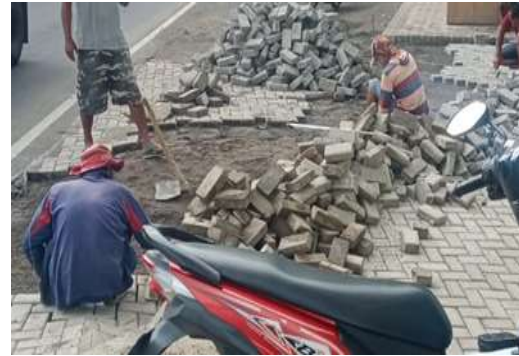
Gambar 5 Perbaikan Lahan Parkir Sumber : Data Primer (2023)
