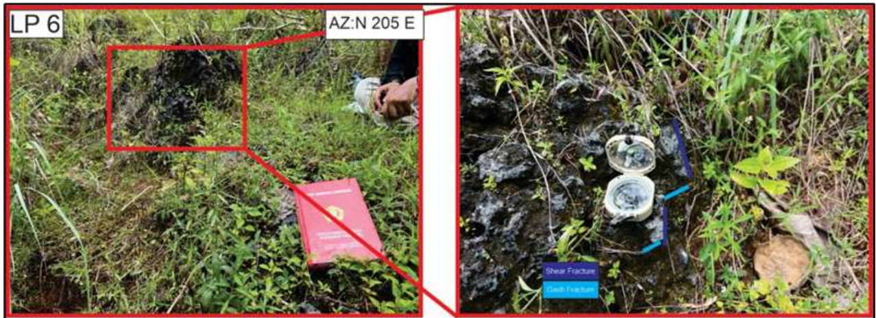
Gambar 9. Foto sesar 3 pada lokasi pengamatan 6 menunjukkan kehadiran indikasi pergerakan berupa shear fracture dan gash fracture
