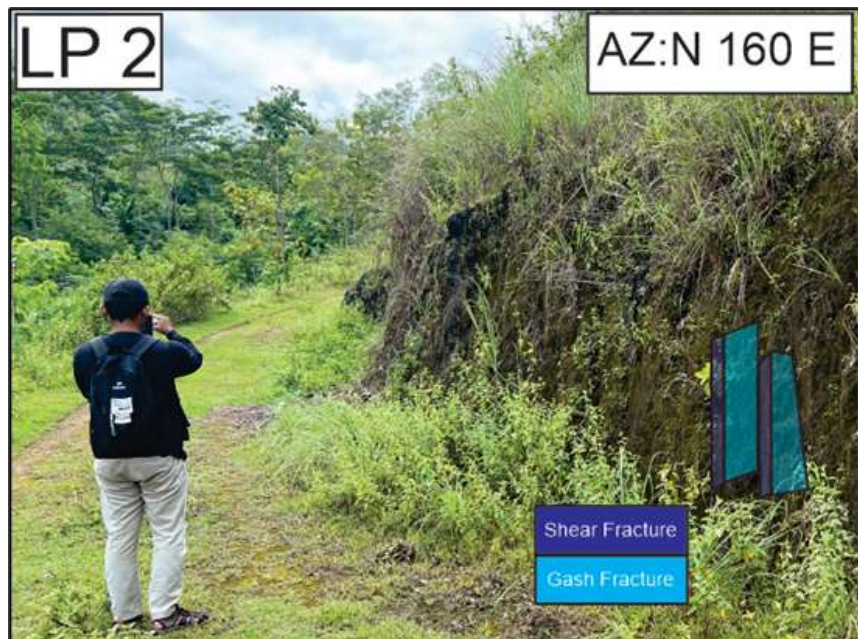
Gambar 7. Foto sesar 1 pada lokasi pengamatan 2 menunjukkan kehadiran indikasi pergerakan berupa shear fracture dan gash fracture .
