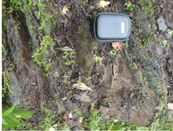
Foto 8. Penampakan Struktur Sheeting Joint pada Lp 37, arah kamera N 20°E
