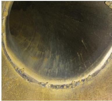
Gambar 5. Cacat Incomplete Penetration pada pengelasan pipa
