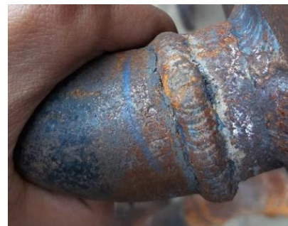
Gambar 4. Cacat Undercut pada pengelasan pipa
