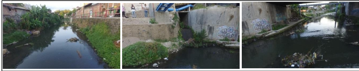
Gambar 15. Kondisi sungai sekitar jembatan KHA Dahlan
