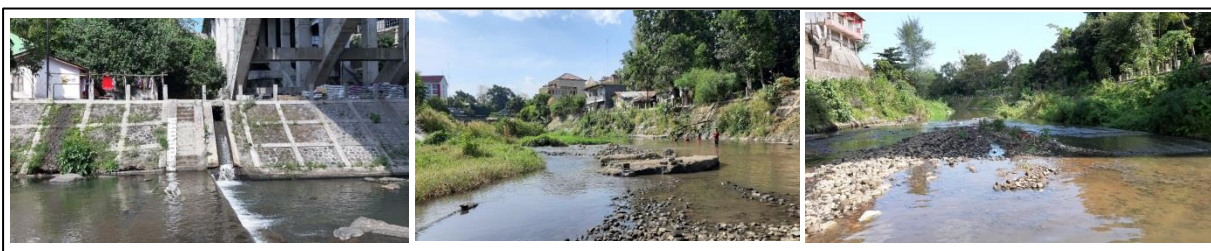
Gambar 11. Kondisi lingkungan sungai sekitar Jembatan Sarjito
