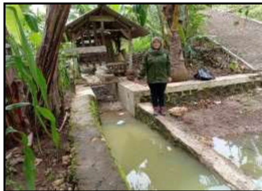
Gambar 3. Saluran Air Masuk Telaga Sumber: Dokumentasi (2020)
