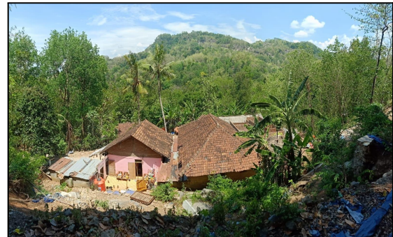
Gambar 9. Kondisi Rumah Terdampak (Sumber: Survey, 2021, Kamera Menghadap Timur)
